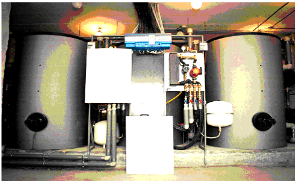
Рис. 4. Бак и комплектная станция в доме №23 на ул. Сакко и Ванцетти
